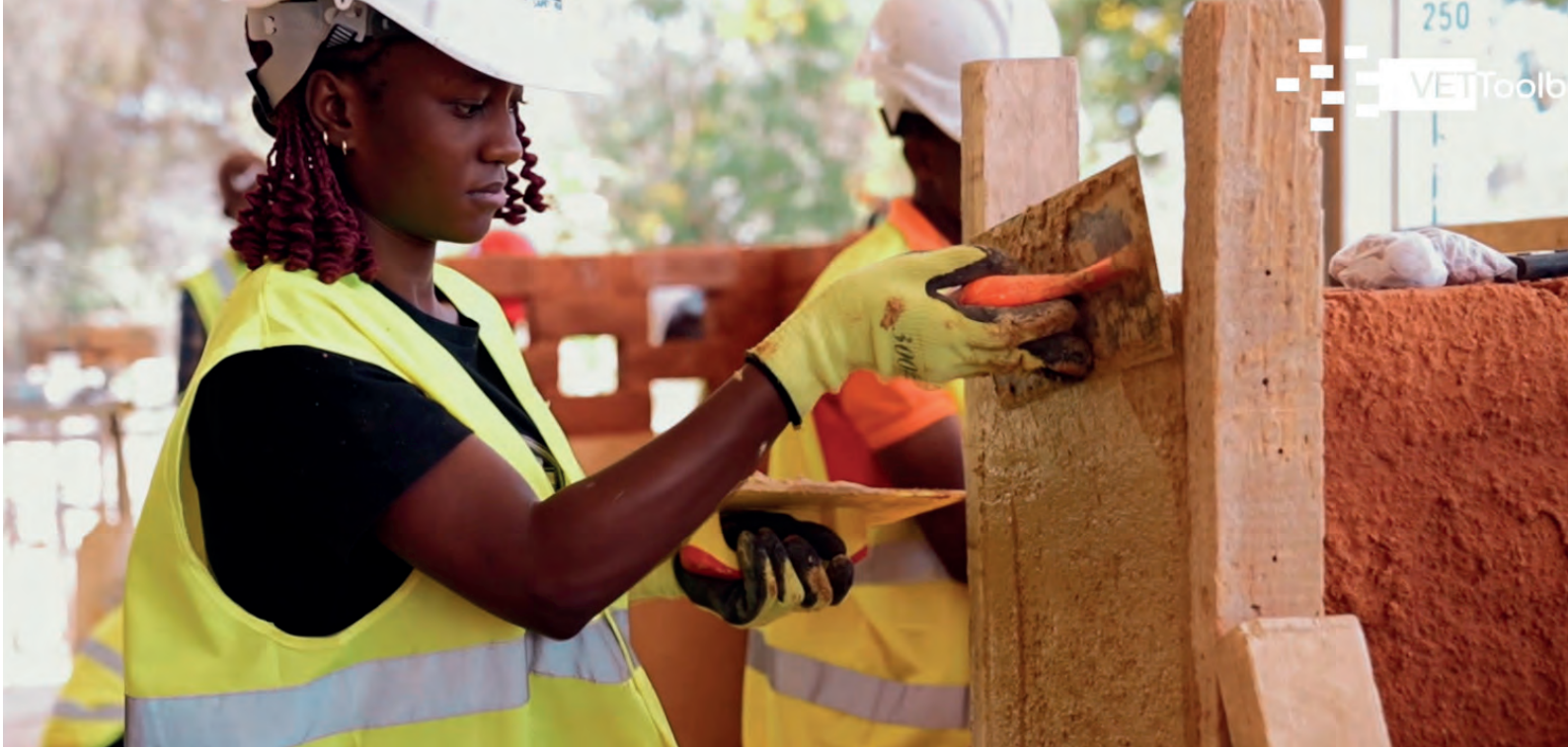
Formation Jang Ban en écoconstruction soutenue par la VET Toolbox 2 au Sénégal
