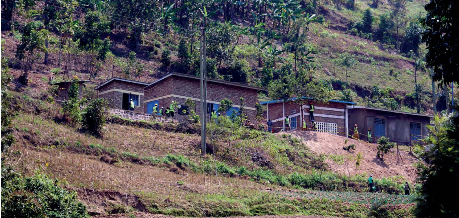
Réhabilitation d’une station de pompage pour le système d’approvisionnement en eau au Rwanda
