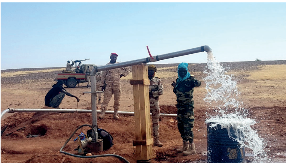
Essais de pompage dans le département de Tahoua suite à la finalisation des travaux de forages sécurisés par les Forces armées nigériennes
