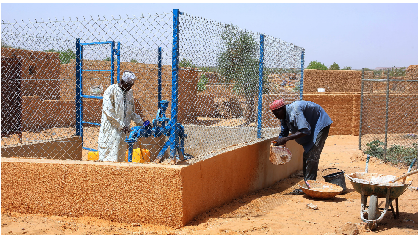
Mini adduction d'eau potable (AEP) en réhabilitation dans le village de Toudou/Département de Filingué.
